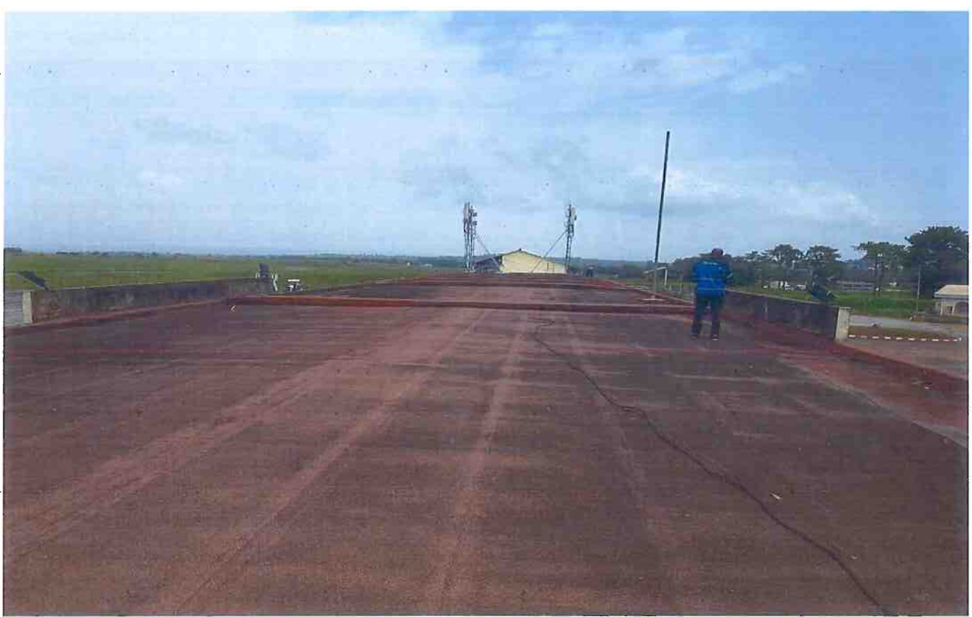
Image du complexe d'étanchéité vieillissant
